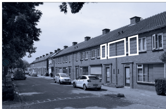
5 Details in metselwerk, sterke ritmiek in gevels
