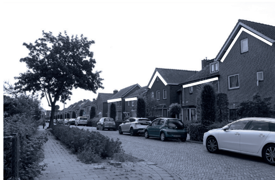
3 Grote daken met overstekken
