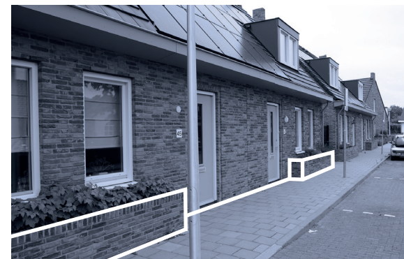
6 Details in metselwerk, sterke ritmiek in gevels
