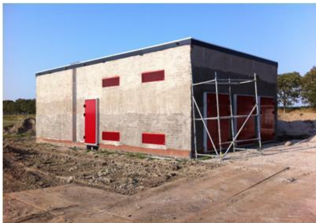
Figuur 8. Gasontvangstation in aanbouw
