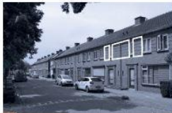
5 Details in metselwerk, sterke ritmiek in gevels
