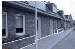
6 Details in metselwerk, sterke ritmiek in gevels
