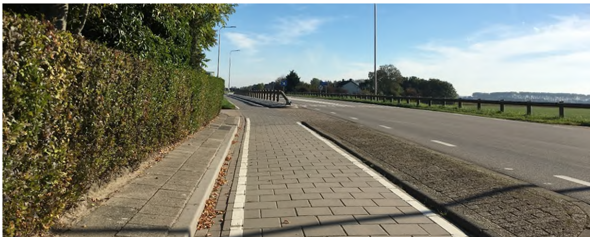
Figuur 8 Geleiderails nabij de oostelijke komgrens
