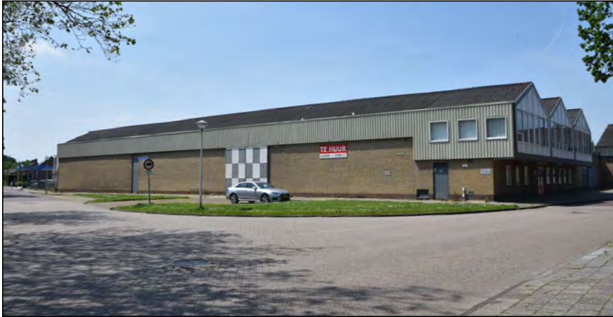
Figuur: het plangebied bestaat uit diverse loodsen, waarvan een gedeelte een spouw heeft. Hier kunnen vleermuizen verblijfplaatsen hebben.
