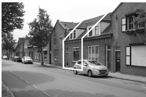
3 Voordeur aan de straat
