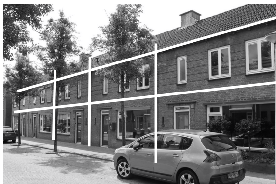
1 Gaten in metselwerk
